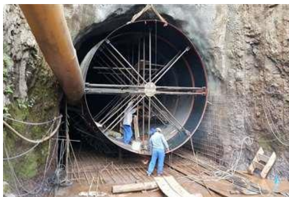
FIGURA 3- Instalação de turbina no túnel onde foram coletadas as amostras.
